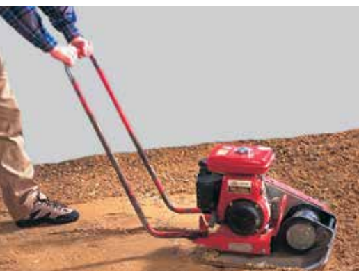
Terrænet afrømmes til bæredygtigt niveau. Eventuelt afretningsgrus udlægges og vibreres.
