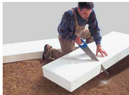
Sundolitt udlægges i forbandt. Start i sokkelhjørne.
