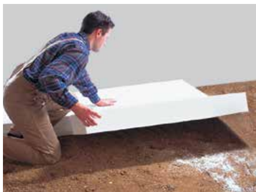
Sundolitt-plader tilpasses nemt med almindeligt håndværktøj.
