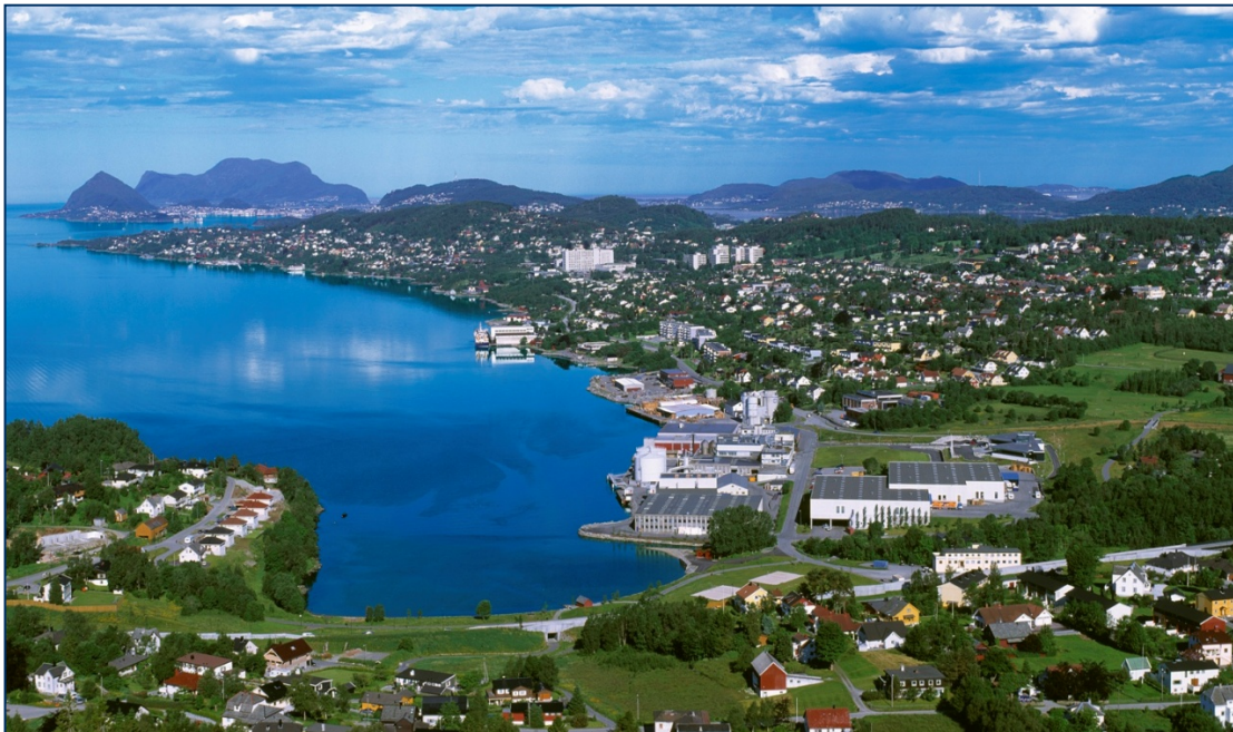
Figur 4.8 - Foto over Sundes sitt anlegg i Spjelkavik. Husene til venstre for sundet ligger omlag 200 meter i luftlinje fra anlegget
