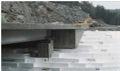
CIMENTACIÓN DE CARRETERAS
