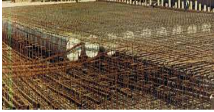
ENCOFRADO Y RELLENO LIGERO
